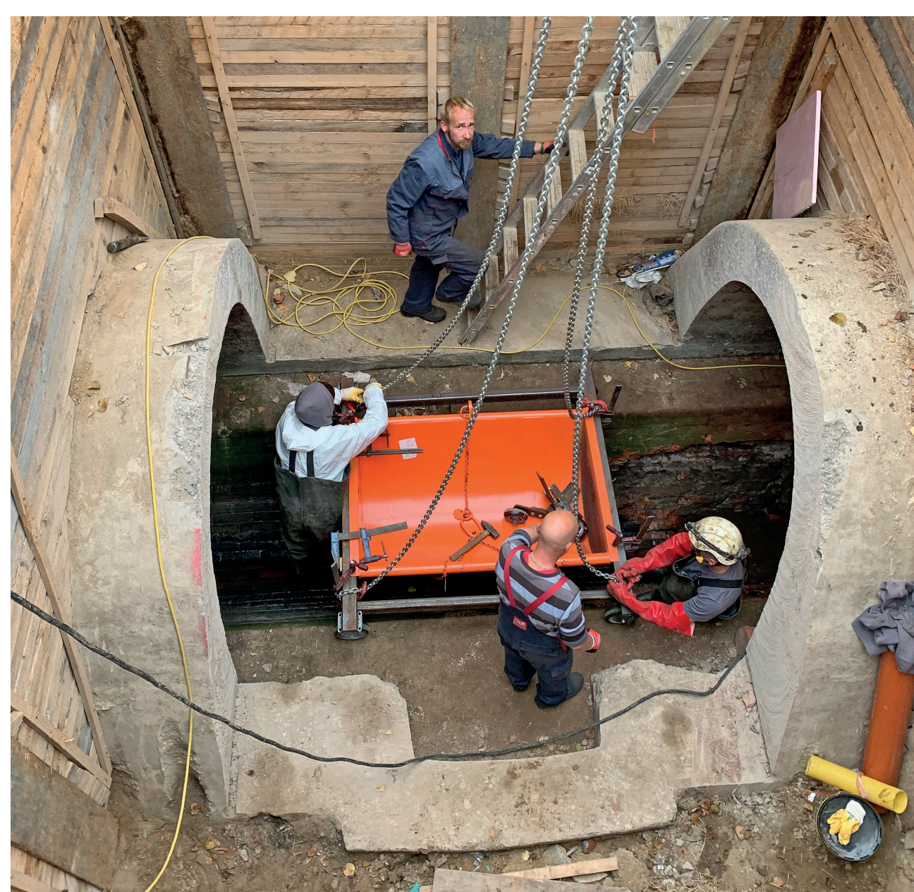
Baugrube und Altkanal
